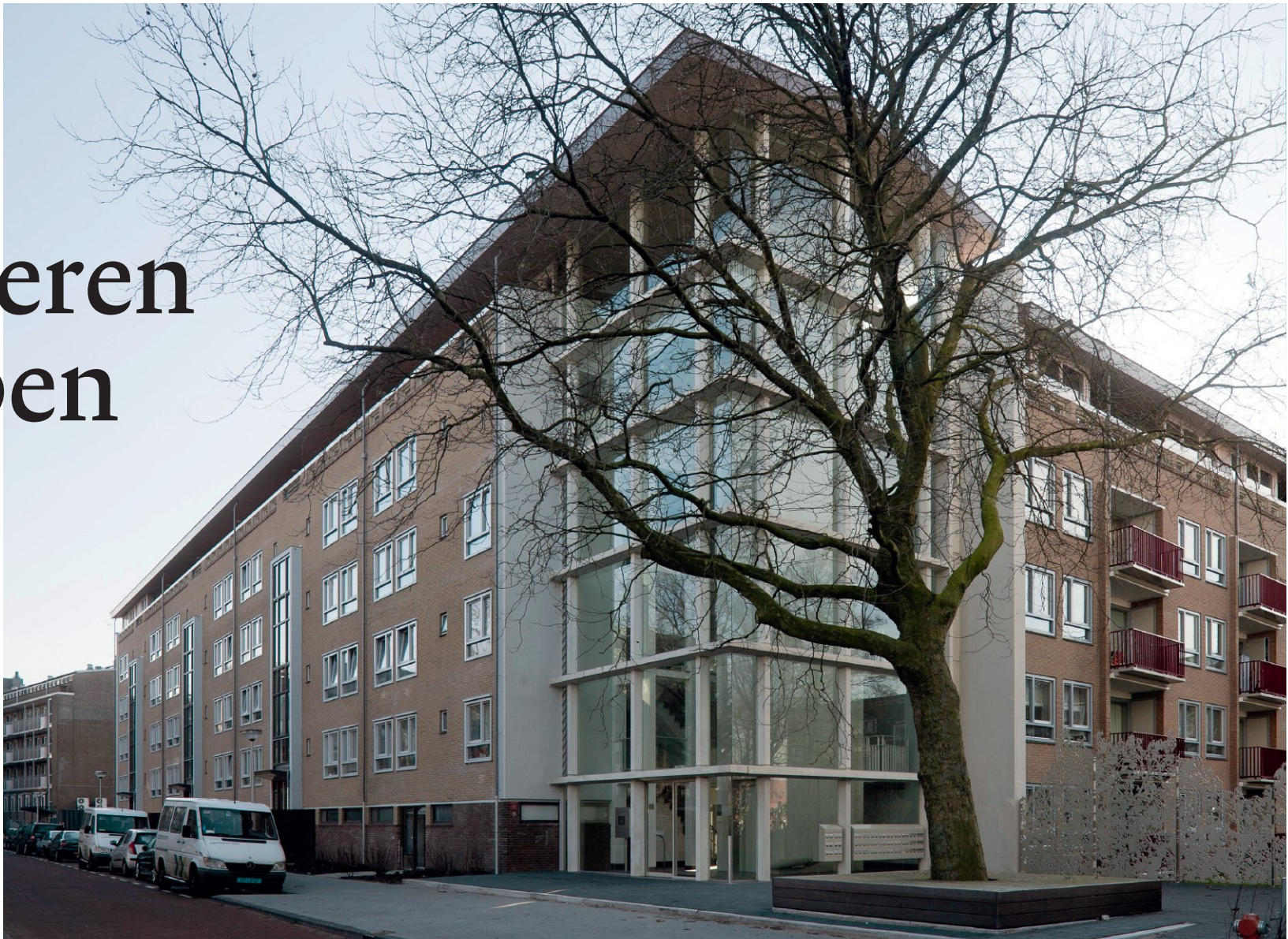
Verbouwd wooncomplex van Dudok in het Amsterdamse Geuzenveld
